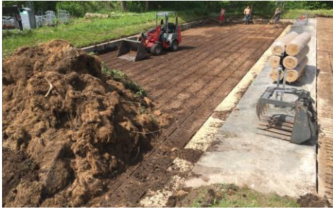
Abtrag altes Material
