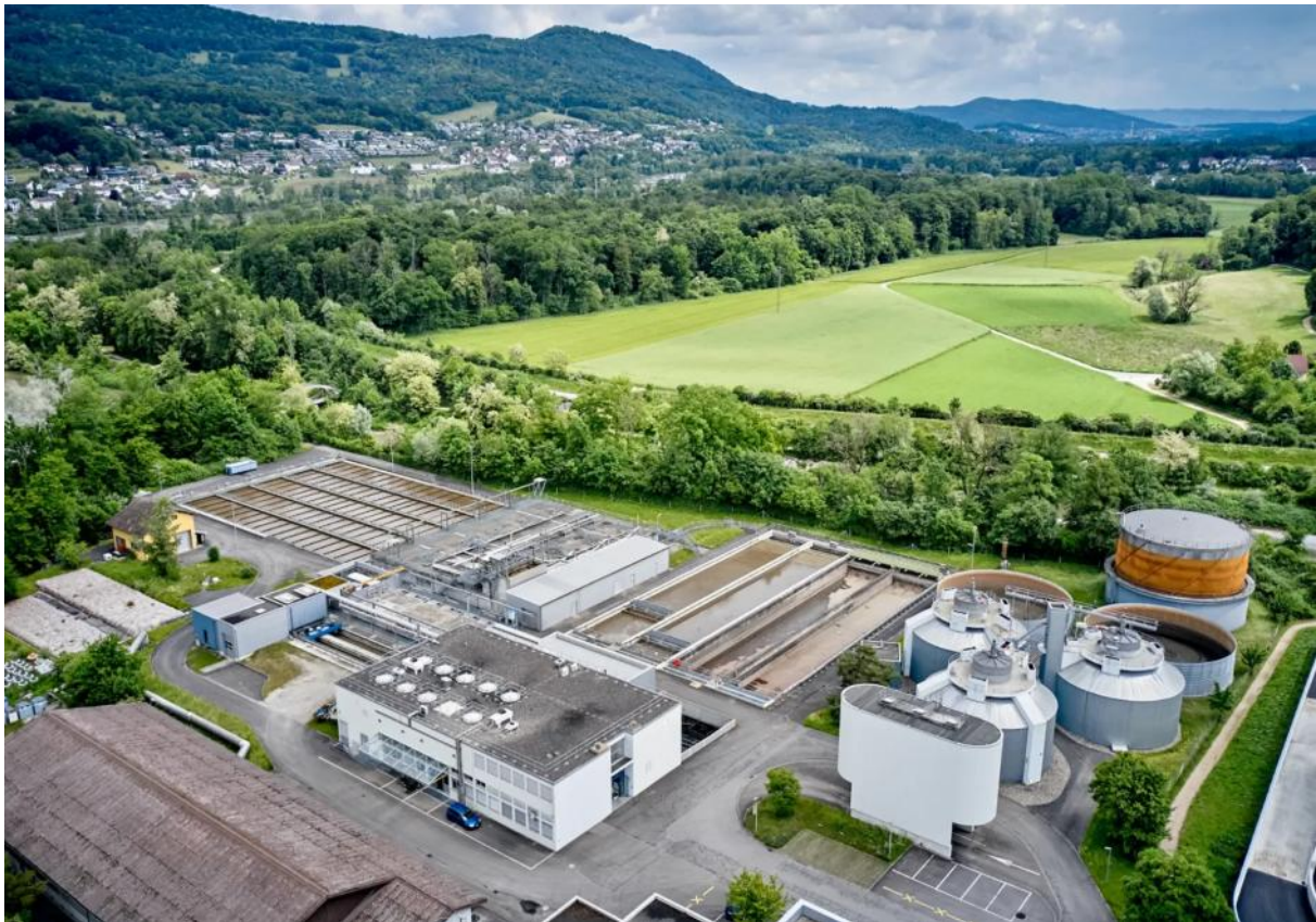
Blick nach Osten auf die heutige ARA und ihren geplanten neuen Standort im Gebiet Lähe/Salenmatt
